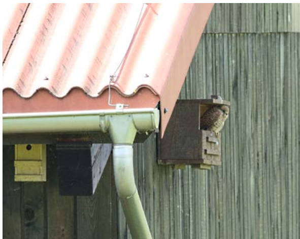
Nichoir à faucon crécerelle sur un bâtiment agricole. © M.Farine
